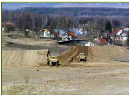
Výstavba hřiště, v pozadí obce Dolní Rychnov, foto V. Podracký.
