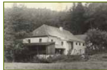
Mlýn v Dalešicích.
