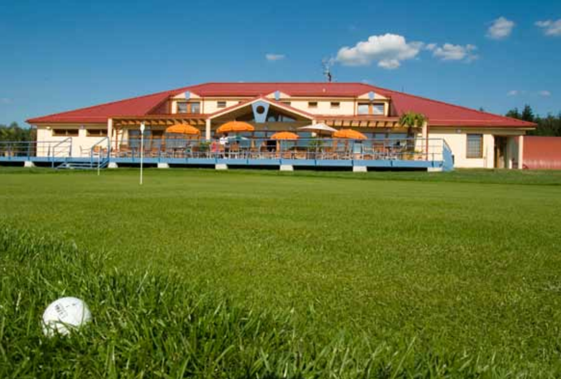
Budova klubu a restaurace golfového hřiště v Dolním Rychnově, foto V. Podracký (viz článek na str. 29).
