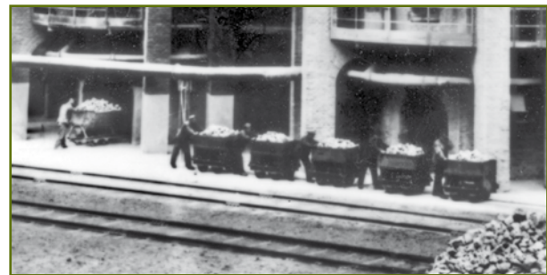
Jedna z mála fotografií, která ukazuje úzkorozchodku v provozu. Dělníci tlačí vozíky u peci vápenky. Práce to byla namáhavá a nebezpečná - 30. léta.
