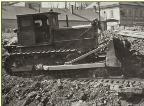
První práce na staveništi v roce 1955.
