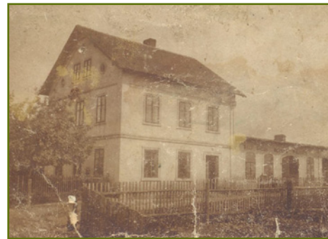
Dům č. p. 18 v Liboci v roce 1925 - v přístavku vpravo byla dílna.
