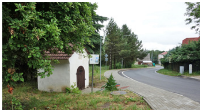
Nový chodník v ulicích Loketská a Hornická kolonie v Novém Sedle.
