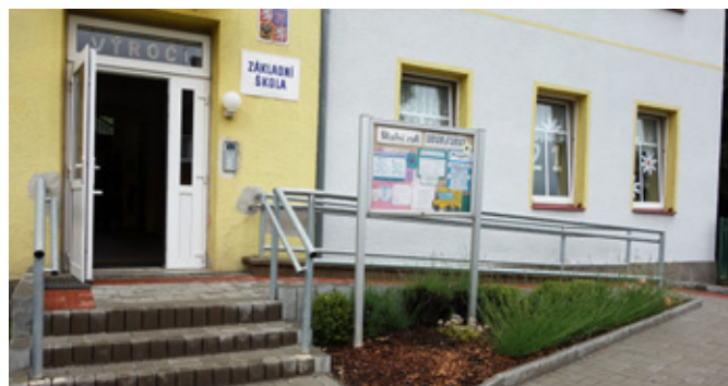
Bezbariérový přístup do budovy ZŠ Královské Poříčí.
