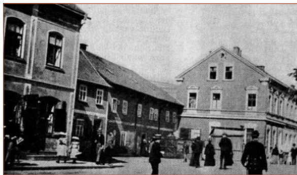
Mlýn čp. 335 po snížení střechy a novostavba domu čp. 1042, cca 20. léta 20. století. Archiv autora
