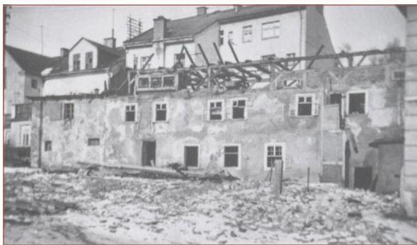
Demolice mlýna – pohled na zadní stranu s náhonem směrem od Lipového náměstí okolo roku 1950. Archiv autora.
