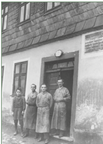
Průčelí domu v Oberegasse čp. 623 sousedící s rodným domem čp. 398 Franze Keila. 20. léta 20. století.
