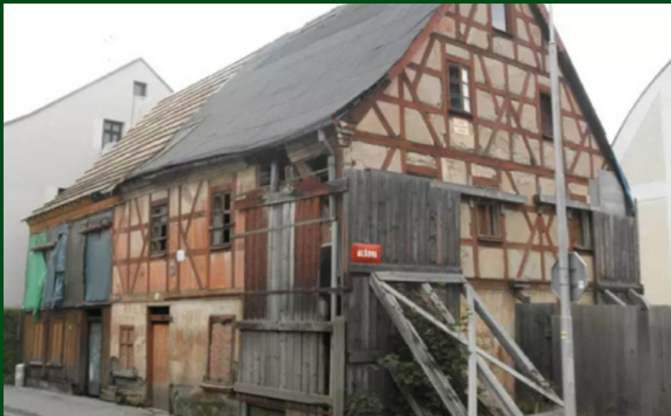
Hrázděnka před rekonstrukcí. (viz článek na str. 23)
