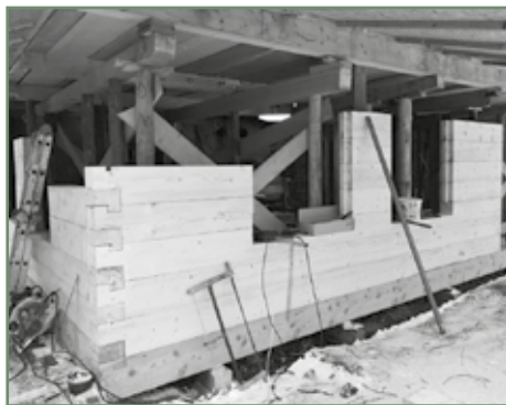
Rekonstrukce obvodových stěn.
