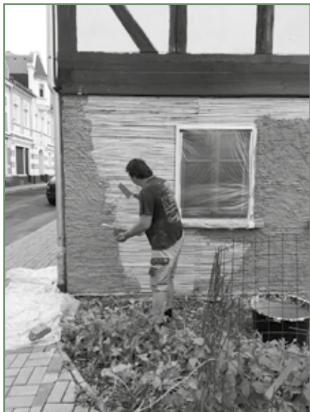
Během oprav fasády.
