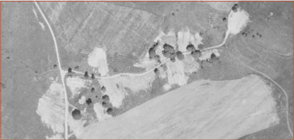
Obr. 8: Žitná (okr. Sokolov), výřez z leteckého snímku pořízeného 15. června 1957. V místech bývalé vesnické zástavby zůstaly jen prázdné plochy s dobře patrnými stopami demoliční činnosti. Originál uložen v Zeměměřickém úřadu v Praze.
