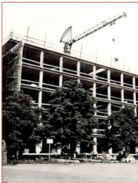
Výstavba správní budovy v roce 1968.
