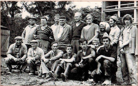
Kolektiv pracovníků stavby administrativní budovy v areálu Báňských staveb v Dolním Rychnově.
