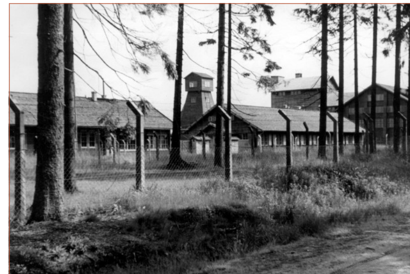
Úpravna cínu na Rolavě těsně po skončení války.
