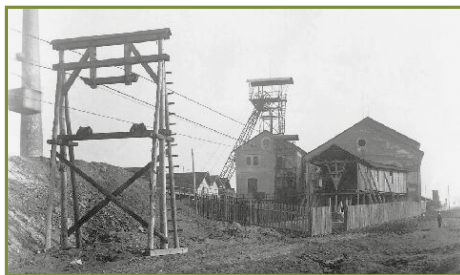
2 700 metrů dlouhá visutá lanová dráha typu Karl Gasch Chodov přepravovala uhlí z dolu Poldi v Je-nišově k nakládkě na nakládací rampu na nádraží v Chodově.
