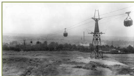
Visutá lanová dráha typu Pohlig, která dopravovala uhlí z dolu Anežka v Lískovce na třídiřnu Anežka do Svatavy – Davidova.
