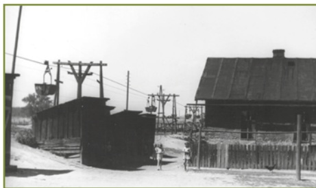
Visutá dráha typu Karl Gasch Chodov dopravovala uhlí z dolu Anežka v D. Rychnově k železniční vlečce k nakládkě do vagonů. Domy v sousedství je dnes již neexistující dělnická kolonie v D. Rychnově.
