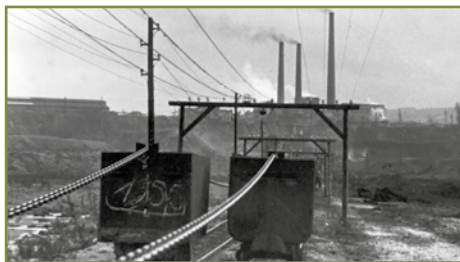
Pozemní řetězová dráha, dopravovala uhlí z lomu Lu-itpold (Antonín) do třídiřny a dále do dolnorychnovské elektrárny (v pozadí). Stav v roce 1960.
