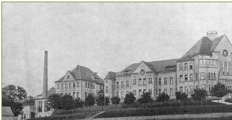
Pohled na nemocnici krátce po dokončení.
