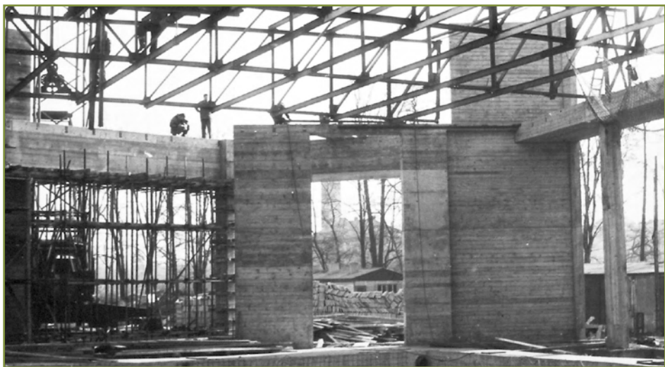
Výstavba bazénu v roce 1971.
