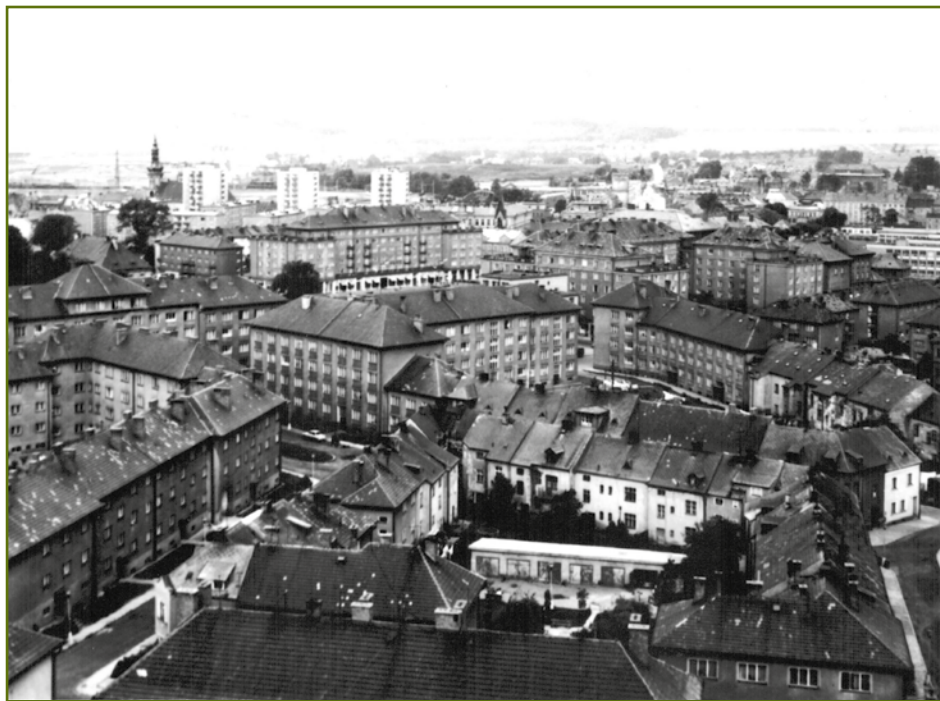
Celkový pohled na sídliště z nemocnice.
