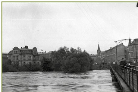
Valící se voda pod starým sokolovským mostem z roku 1876. Sbíрка autora.
