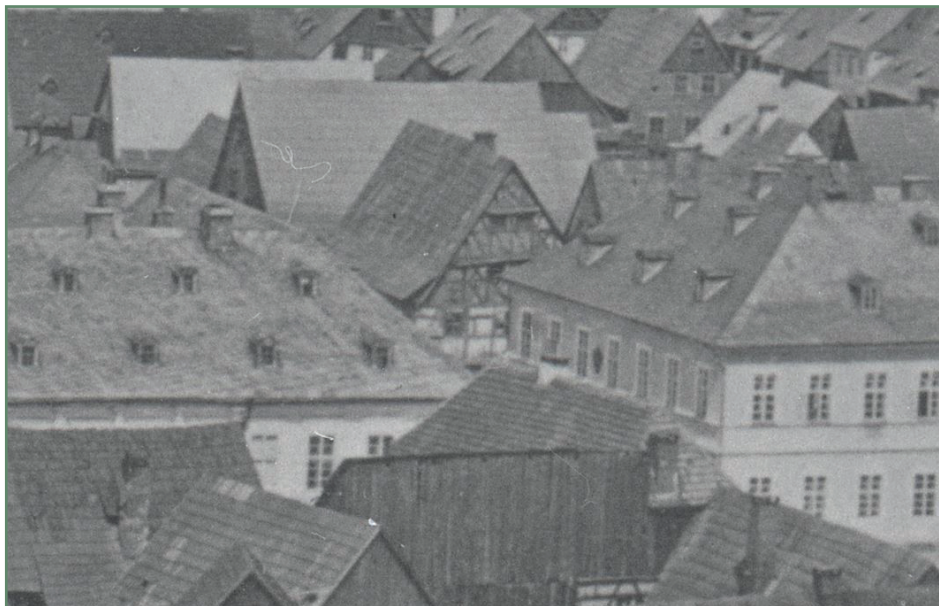
Střed Kraslic na přelomu 70.-80. let 19. století. Ve středu fotografie je vidět původní hrázdný dum čp.2, který musel uvolnit místo pro novou radniční budovu dle planu O. Ehlena.
