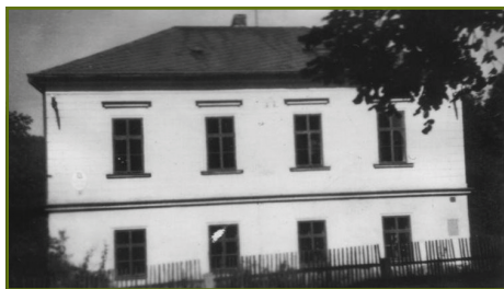
Škola v roce 1958 (zřejmě po opravě).
