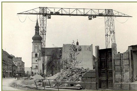
Dům při demolicí v roce 1962. Je již vidět stavba panelového domu v Rooseveltově ulici.
