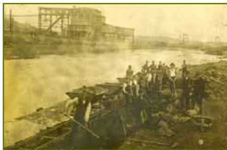
Třídírna Jiří v roce 1925. Visutá lanová dráha vlevo zauhlovala třídírnu Jiří z lomu a dolu Jiří v Lomnici, visutá lanová dráha vpravo dopravovala uhlí z třídírny Jiří do chemické továrny ve Falknově. Dělníci zpevňují a utěsňují pravý břeh řeky Ohře proti průsakům do sousedního lomu Bohemie.
