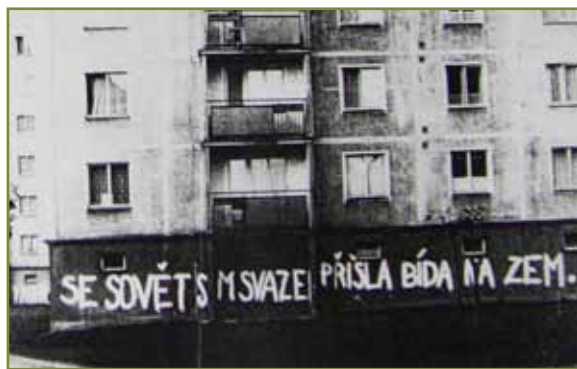
Protiokupační nápis na jednom z panelových domů u sokolovského kostela.
