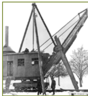
Montáž parního lopatového rýpadla Orenstein a Koppel v Lomnici pro otvírku lomu Jiří v roce 1917.
